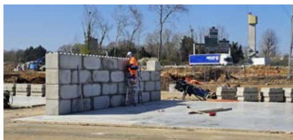
Chantier en cours 1 er avril 2025
