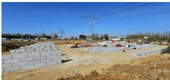
Chantier en cours 1 er avril 2025
