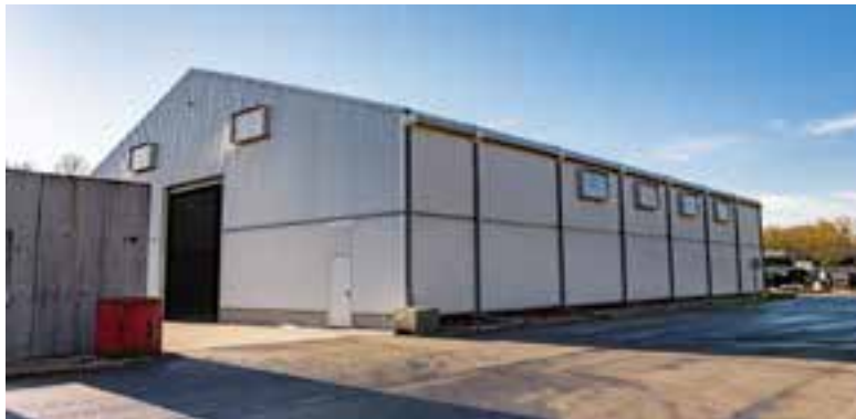
Quai de transfert
